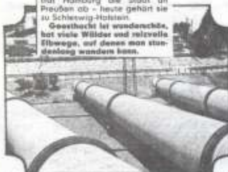
Durch diese drei Röhre wird Elbwasser zum Speicher gepumpt.
